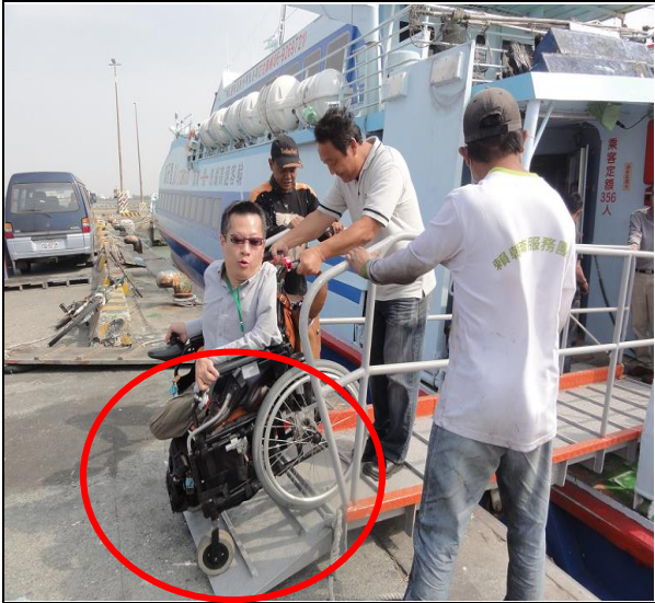
布袋商港無障礙坡道 (接觸陸地坡道過陡)
